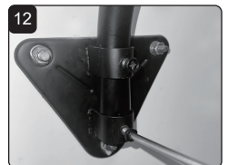
12 Bevestig de driehoek aan de muur en draai de schroeven vast
